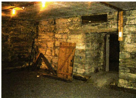
Figur 104: Munkekjelleren i rom 001, med døråpning til rom 002. De mørke veggene er trolig sot fra en brann. Foto: Arkipartner i 2003. 639 Nå er veggene hvitkalkede.
