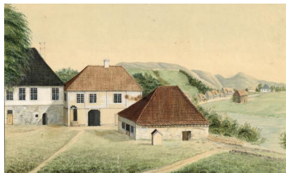
Figur 96: Noen av bygningene på Kongsgård. Hovedbygget er til venstre. Vaktmesterboligen er i midten. Stallen er delvis foran vaktmesterboligen. Brønnhuset er det lille bygget foran stallen. Breiavatnet er til høyre. Tegning: Thorvald Christensen i 1845. 589
