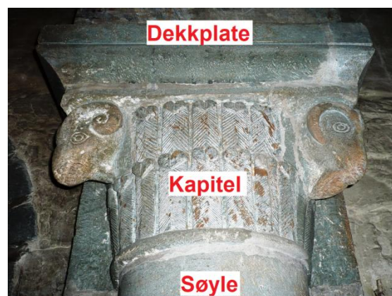
Figur 75: Toppen av steinsøylene i Domkirken består av et utsmykket søylehode (kapitel), og en firkantet dekkplate (abakus) øverst. Platene danner underlaget for de langsgående rundbuene (arkader) i kirkeskipet og takene i sideskipene. Utformingen av kapitelen varierer fra søyle til søyle. De er av varierende alder og de er laget av flere byggmestre. Detaljutformingen forteller om når de ble laget, og hvor byggmesteren hentet erfaringene fra. 404 Foto: Arne Kvitrud i 2011.
