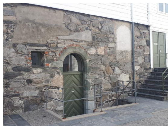
Figur 98: Steinveggen til rom 007 med kjellerdøra. Det er sett fra skolegården mot 008. 007 er den eldste delen av hovedbygget. Veggene og også deler av det innvendige murverket bærer tydelige spor etter ombygginger og reparasjoner. Det er derfor ikke alltid lett å tolke hvordan det var opprinnelig. Foto: Arne Kvitrud i 2023.
