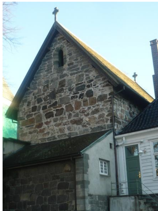
Figur 106: Gavlen til Bispekapellet mot Skolegården. I 1896 ble taket hevet, og vinduet øverst satt inn. Svalgangen foran kapellet er fra 1925. 650 Inne i svalgangen er det en dør inn til kapellet og et kjellervindu. Bak den grønne døra er kapellgangen, som går til dører til kapellet og første etasje i hovedbygget. Foto: Arne Kvitrud i 2020.
