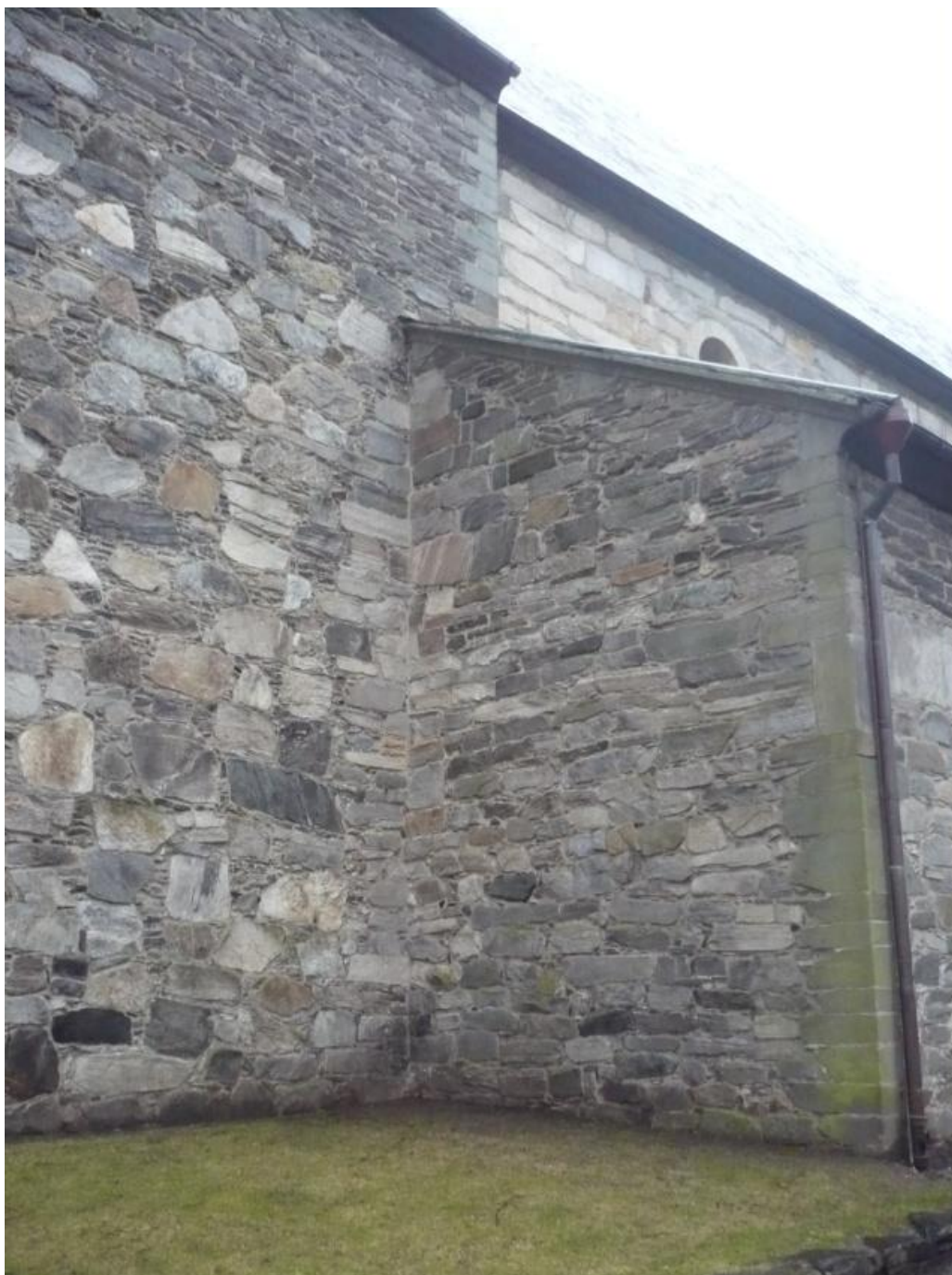
Figur 85: Steinmurene på sørsiden i overgangen mellom vestpartiet og sideskipet. I sideskipet som er til høyre i bildet, er det steinsetting med steinene lagt flatt over hverandre fra ca. 1150. Nederst i vestpartiet, som er til venstre, er det steinsetting fra slutten av 1200-tallet. Det er steiner på høykant og med småstein i mellom. 502
