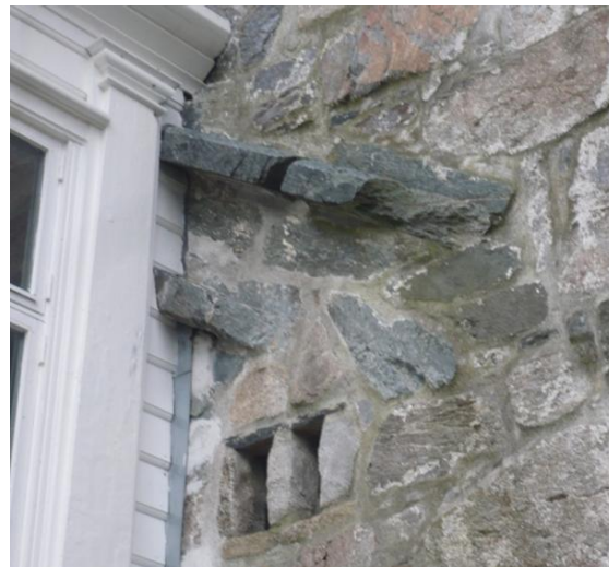
Figur 107: Takrestene på Bispekapellets sørside. Det var enten et overtak og et undertak, eller tak fra to perioder. 657 Åpningen i steinveggen er en nyere ventilasjonsåpning. Foto: Arne Kvitrud i 2015.
