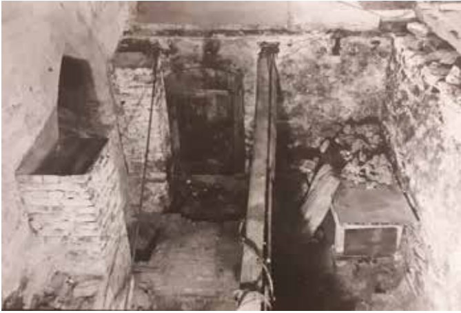
Deler av korkjelleren i Domkirken, der deler av golvet i koret er fjernet. Foto: Gerhard Fischer ca. 1940. 90
