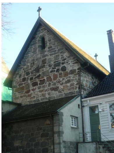
Figur 4: Gavlen til Bispekapellet mot skolegården i 2020. Taket ble hevet i 1896. Svalgangen foran kapellet er satt opp i 1925. 22 Inne i svalgangen er det en dør inn til kapellet og et kjellervindu. Bak den grønne døra er det en gang (kapellgangen), som går til den gamle inngangsdøra til kapellet. Foto: Arne Kvitrud, 2020.
