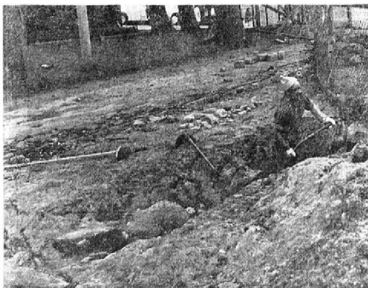
Her er grunnmuren kommet fram i dagen.
