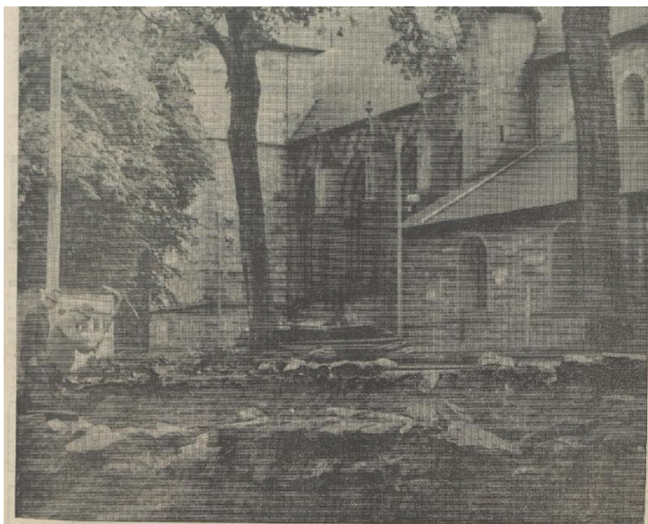
Bildet viser i forgrunnen en del av fundamentet av den gamle Maria-kirken som ble revet i 1883. I disse dager foregår gravingsarbeidet under ledelse av arkitekt Ola Ogar Svendsen fra Riksantikvariatet. Vi ser Domkirken i bakgrunnen.
