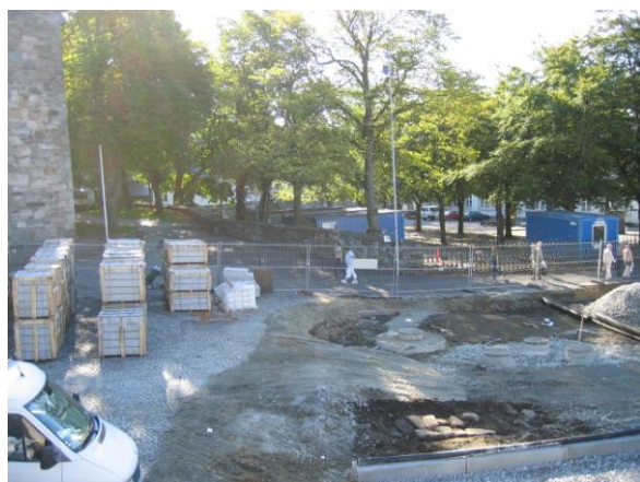
Figur 9: Utgraving ved den sørlige risten til kirkegården. En ser at steingjerdet har en knekk bort fra Domkirken. Steingjerdet gikk på 1700- og 1800-tallet trolig like til venstre for den store kummen midt på bildet (jmfør figur 8). Foto Stan Reed, NIKU, 2006.
